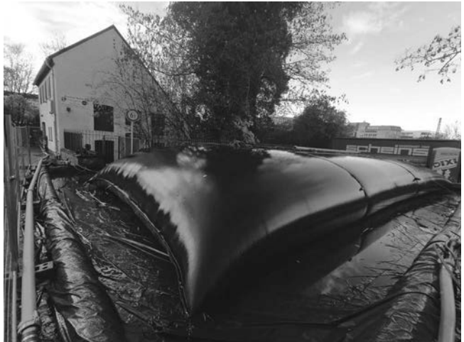
Bild oben: Rund um die Buscher Mühle wurde in Dezember gearbeitet. Bild unten: In diesem Sack wird der Schlamm bis März getrocknet.
